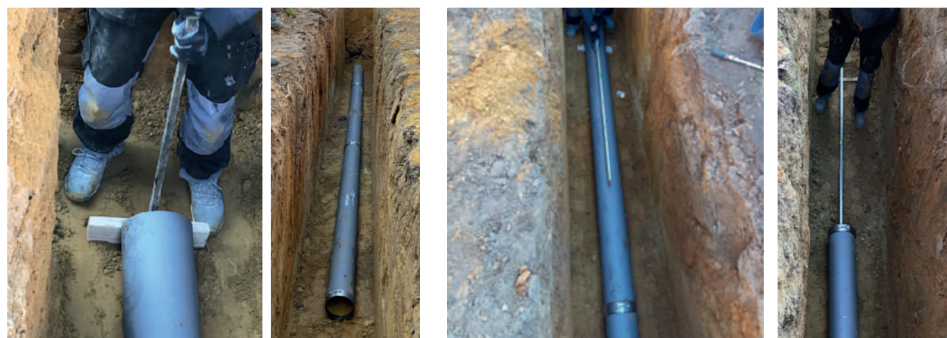
Mise en place des tuyaux dans la tranchée
